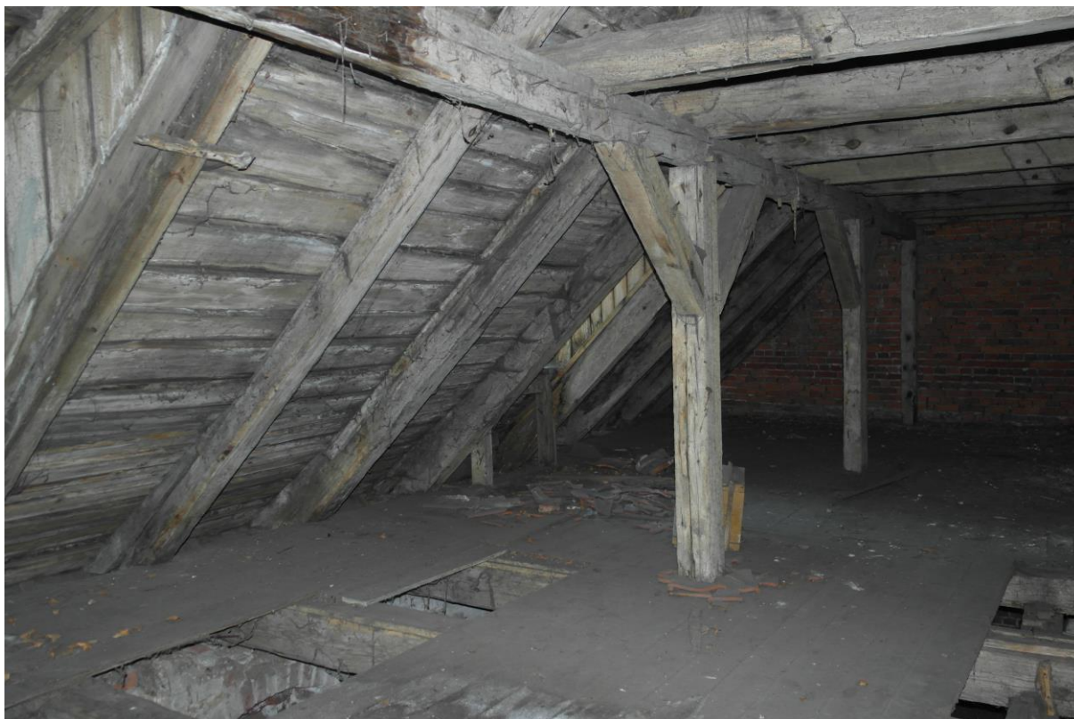
Fot. 11. Wieżba dachowa wozowni.
