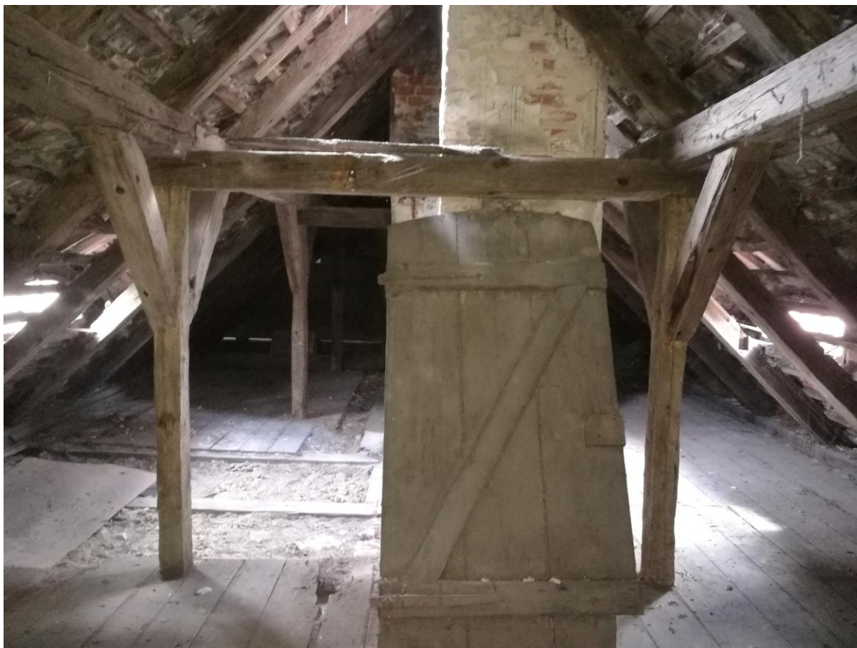
Fot. 15-16. Wieżba dachowa łącznika pomiędzy skrzydłem północnym i wschodnim.
